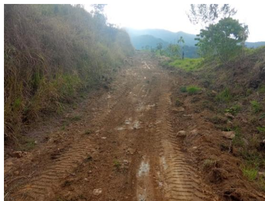
Figura 38 – Estrada de acesso ao plantio após a escavação – Fonte: Ecotec, julho. 2022.
