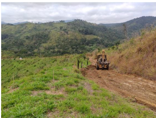
Figura 35 – Atividade de escavação na estrada de acesso ao plantio – Fonte: Ecotec, julho. 2022.
