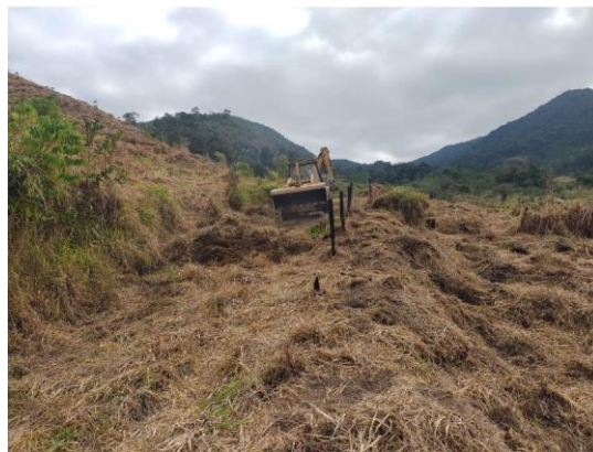
Figura 34 – Limpeza do local do canteiro – Fonte: Ecotec, julho. 2022.
