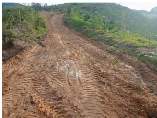
Figura 37 – Estrada de acesso ao plantio após a escavação – Fonte: Ecotec, julho. 2022.
