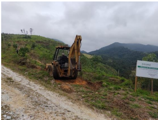
Figura 33 – Início da escavação da estrada – Fonte: Ecotec, julho.2022.
