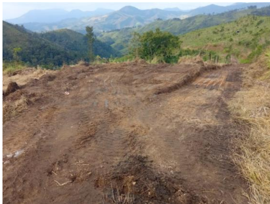
Figura 41 – Local do canteiro após a limpeza – Fonte: Ecotec, julho. 2022.
