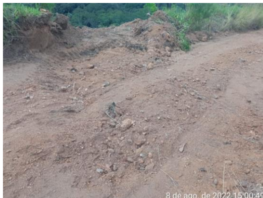
Figura 43 – Saída para escoamento de água na estrada – Fonte: Ecotec, julho. 2022.
