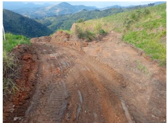
Figura 42 – Saída para escoamento de água na estrada – Fonte: Ecotec, julho. 2022.
