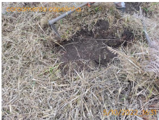
Figura 21 – Atividade de coroamento – Fonte: Ecotec, outubro. 2022.
