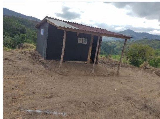
Figura 10 – Finalização do canteiro de obras – Fonte: Ecotec, agosto. 2022.
