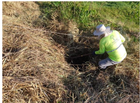
Figura 24 – Atividade de coroamento com utilização da régua – Fonte: Ecotec, agosto. 2022.
