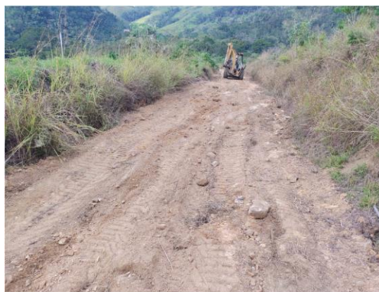
Figura 36 – Atividade de escavação na estrada de acesso ao plantio – Fonte: Ecotec, julho. 2022.
