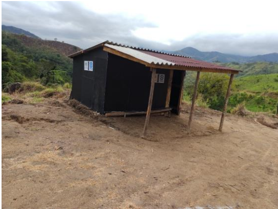
Figura 9 – Finalização do canteiro de obras – Fonte: Ecotec, agosto. 2022.
