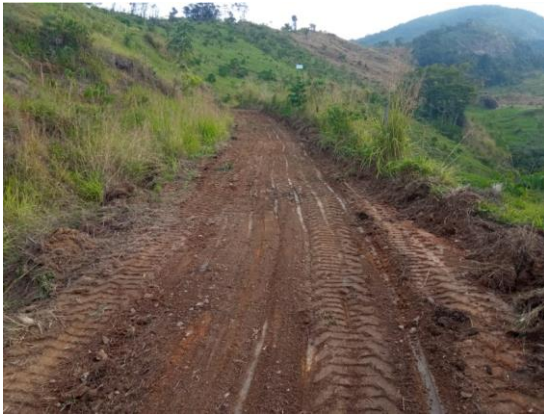
Figura 39 – Estrada de acesso ao plantio após a escavação – Fonte: Ecotec, julho. 2022.
