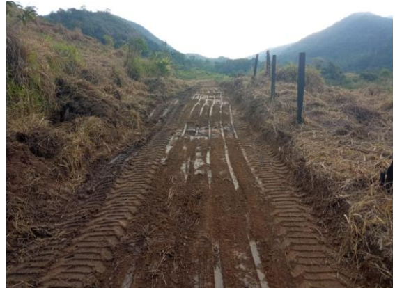
Figura 40 – Estrada de acesso ao plantio após a escavação – Fonte: Ecotec, julho. 2022.
